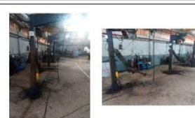
Fotos: Montagem / Vulcanização
