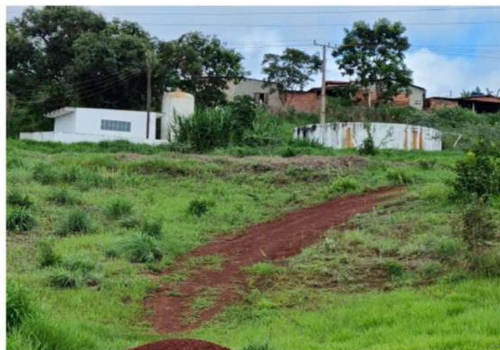
Estação de Tratamento de Água
