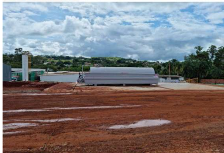
Tanque de Abastecimento de Caminhões
