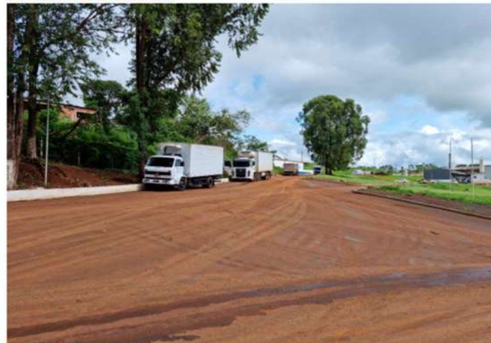
Pátio de Estacionamento de Caminhões
