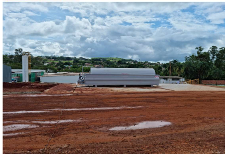
Tanque de Abastecimento de Caminhões
