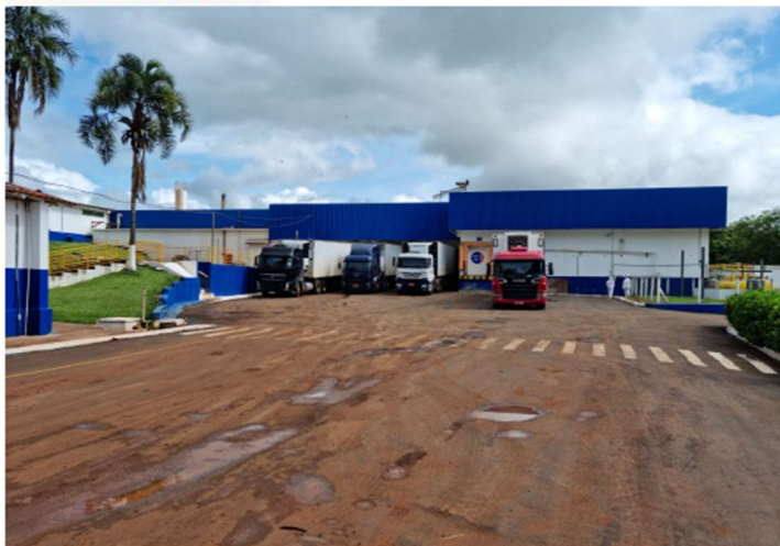
Docas de Carregamento com Osso, Resfriado e Congelado
