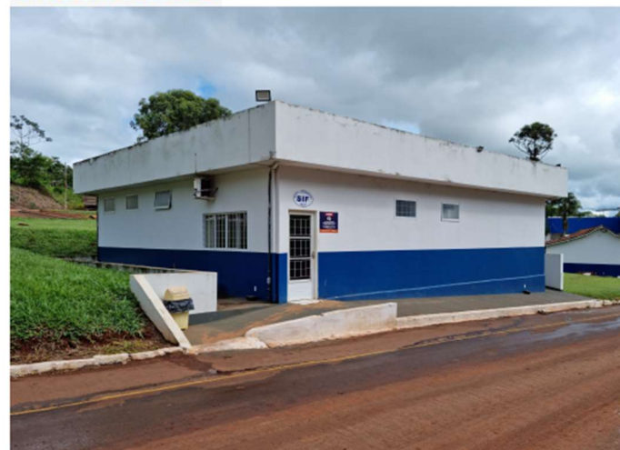
Prédio do SIF – Serviço de Inspeção Federal
