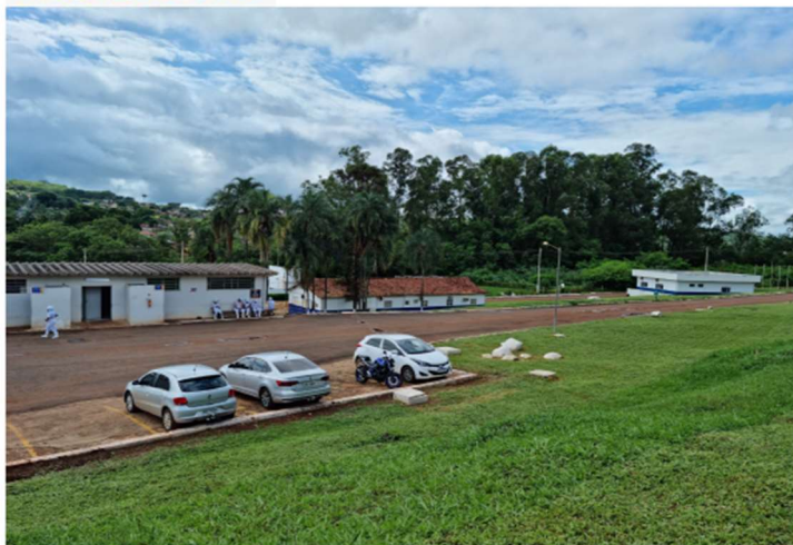
Vista Parcial do Estacionamento Interno e Pátio
